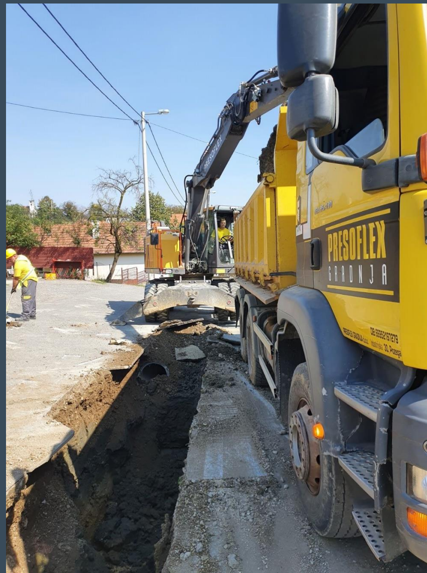
Slika 10 – Izgradnja sustava odvodnje otpadnih voda – Aglomeracija Pleternica
